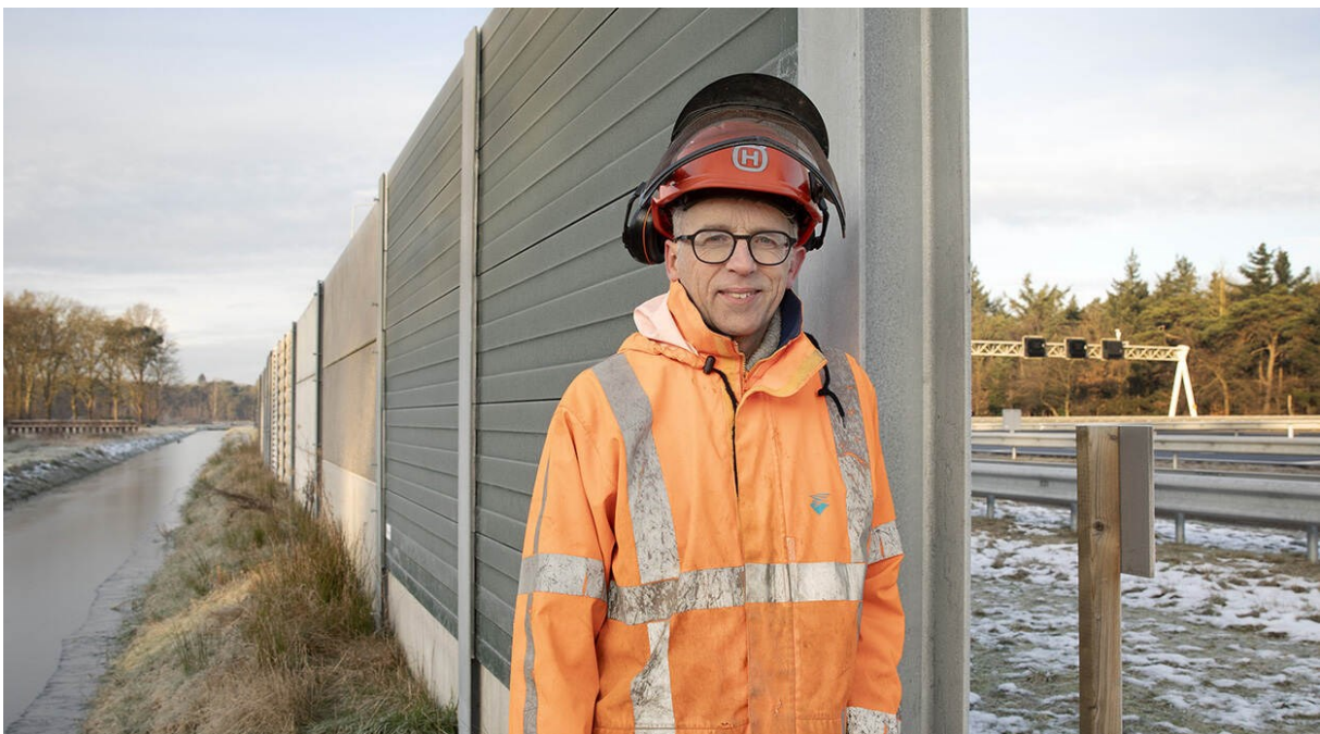
Mosbetongeluidsschermen langs de A58: duurzaam en circulair!
