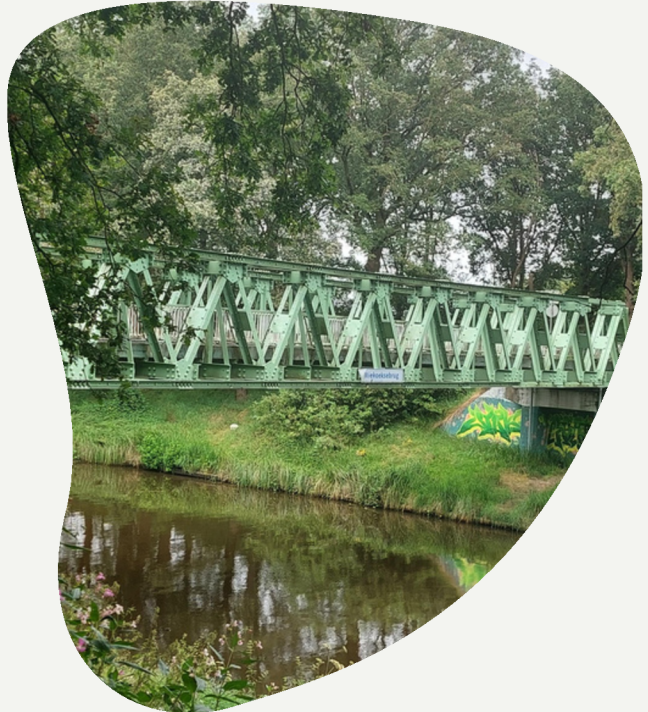
Miekoekse bridge, Wilhelmina canal, Oirschot
